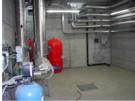
Collettore circuiti termici
