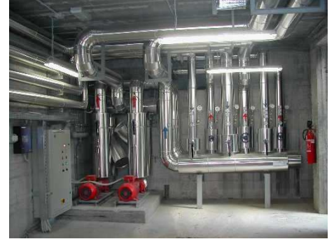
Collettore circuiti termici
