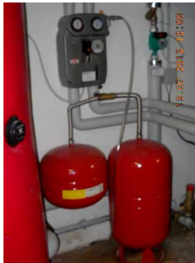
Pompa solare
