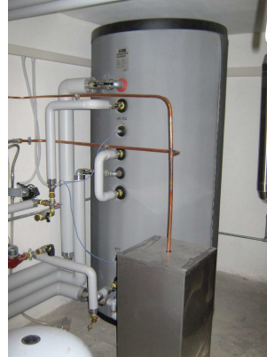
Accumulo solare e sanitario e circuito solare
