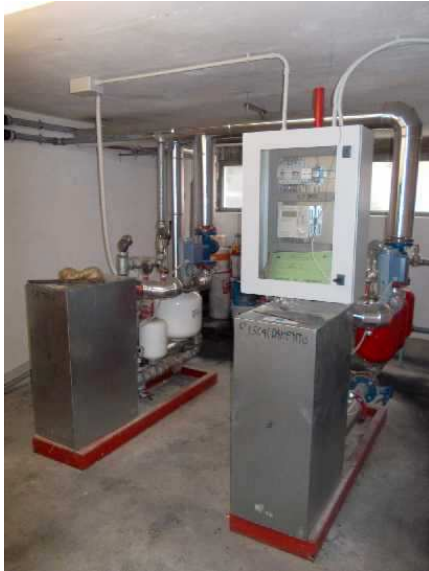
Scambiatori teleriscaldamento
