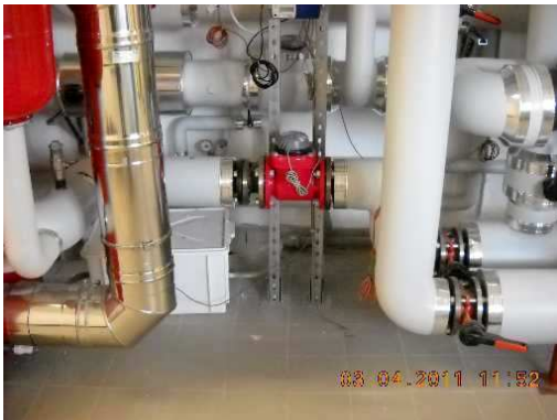
Collettori circuiti termici riscaldamento e sanitario
