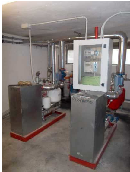
Scambiatori teleriscaldamento
