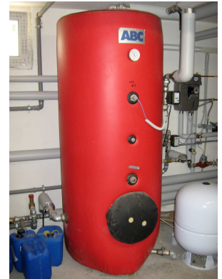
Accumulo solare e sanitario e circuito solare
