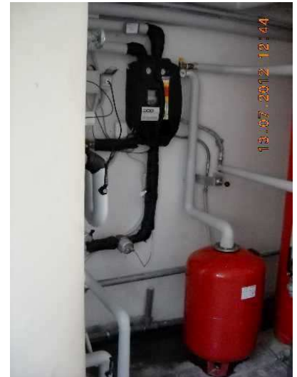
Pompa solare
