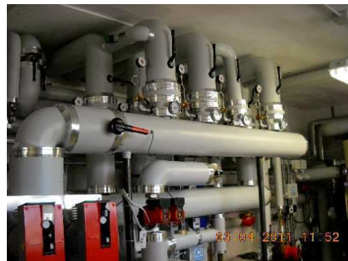
Collettori circuiti termici riscaldamento e sanitario
